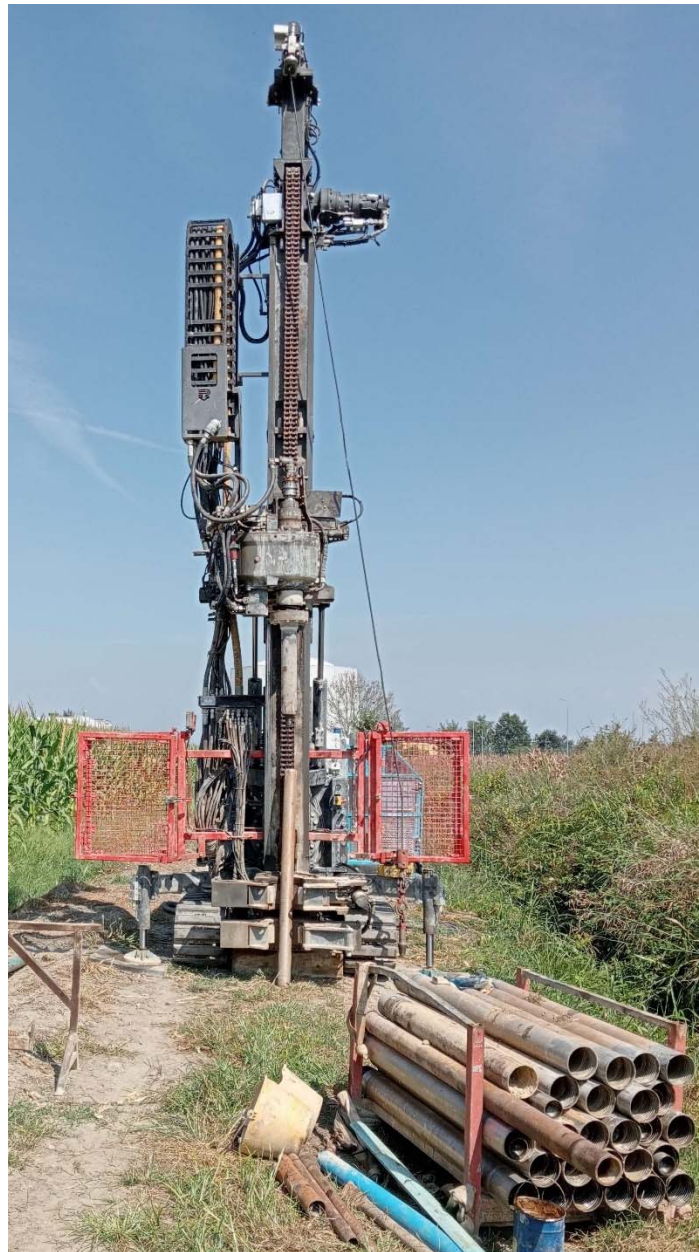
Postazione Sondaggio SB
