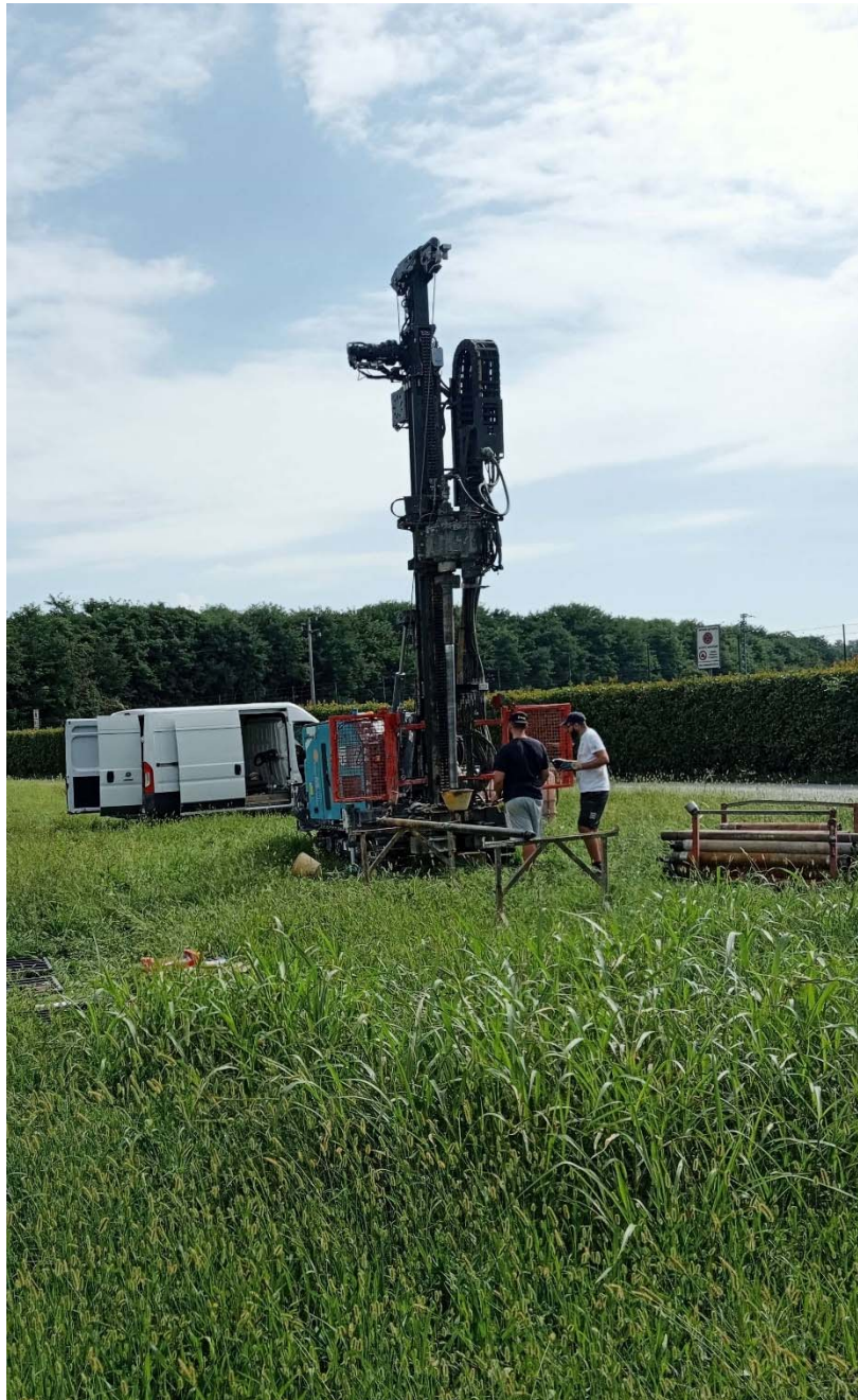
Postazione Sondaggio SA
