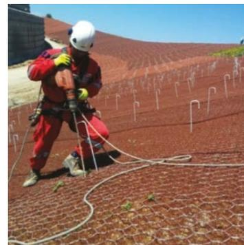
Con riferimento al punto d) dell'elenco precedente, la rete metallica sarà sostituita a sud-ovest (nella strettoia tra C e D, per una lunghezza di circa 450 m) da materassi metallici tipo "Reno", spessore 30 cm, poiché, in caso di piena, la velocità della corrente in golena assume valori dell'ordine di 1 m/s in quel tratto e quindi potenzialmente in grado di assumere un effetto erosivo significativo.
