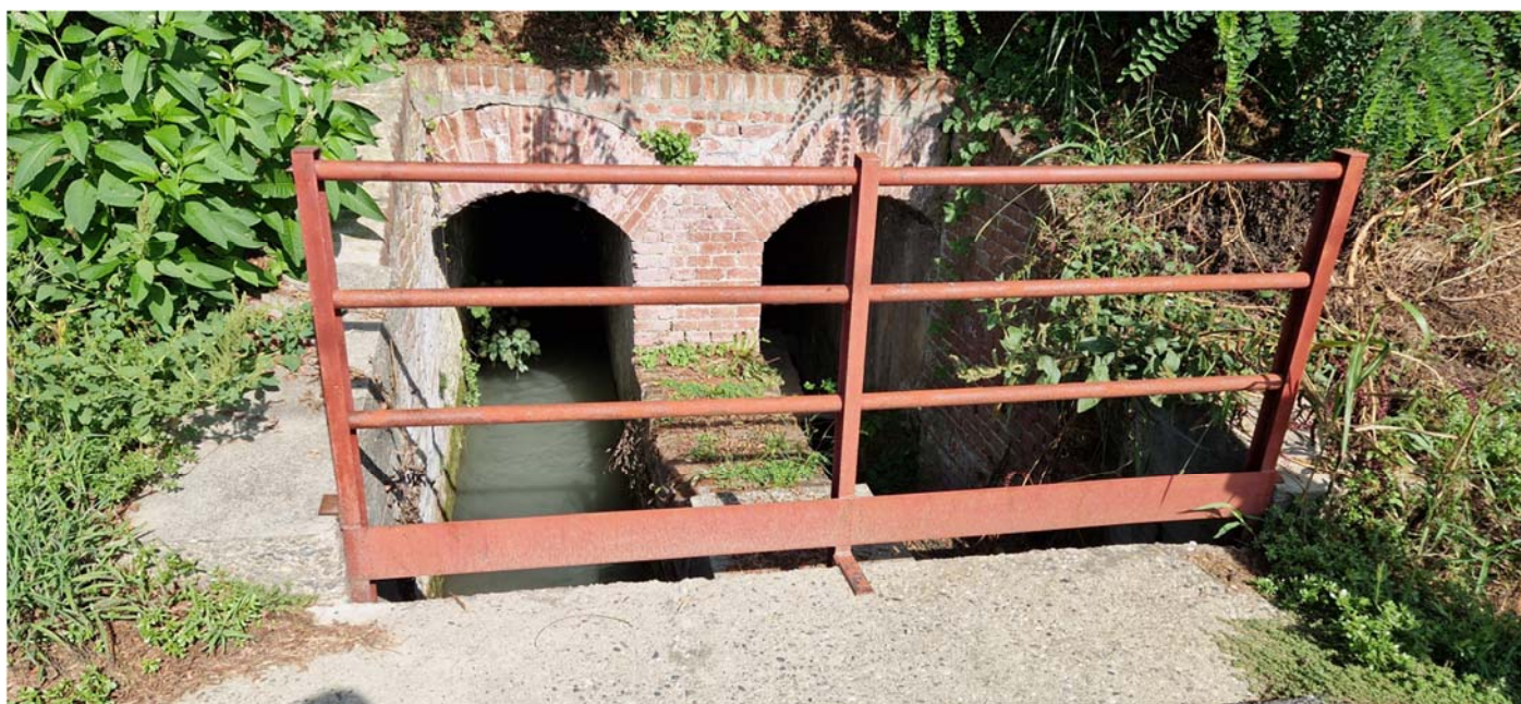
Figura 33- fornic alla base del rilevato del canale Cavour.
