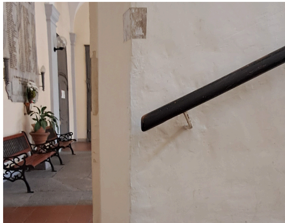
Fotografia corrimano ligneo particolare dell'attacco a muro
