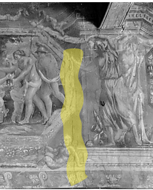
Fotopiano - Particolare della fascia affrescata sulla parete interna nord Particolari delle lesioni
