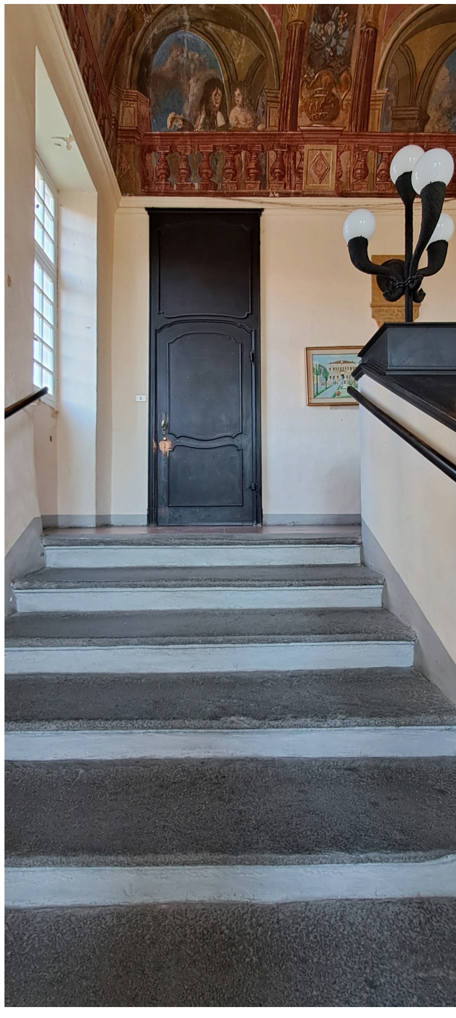
Fotografie generali dello Scalone 3 Seconda Rampa - vista verso il pianerottolo di arrivo
