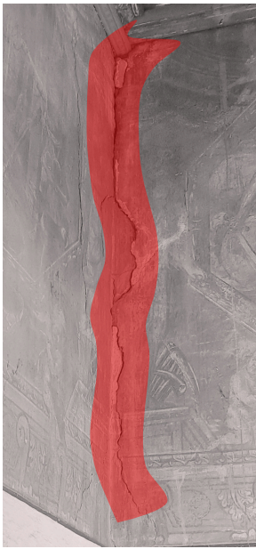
Fotopiano - Particolare della fascia affrescata sulla parete interna est Particolari delle lesioni
