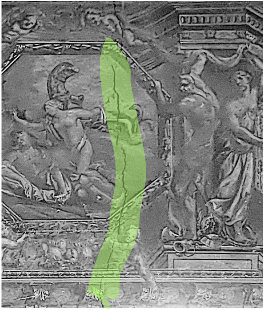
Fotopiano - Particolare della fascia affrescata sulla parete interna ovest Particolari delle lesioni
