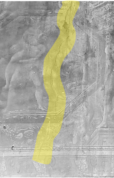
Fotopiano - Particolare della fascia affrescata sulla parete interna est Particolari delle lesioni
