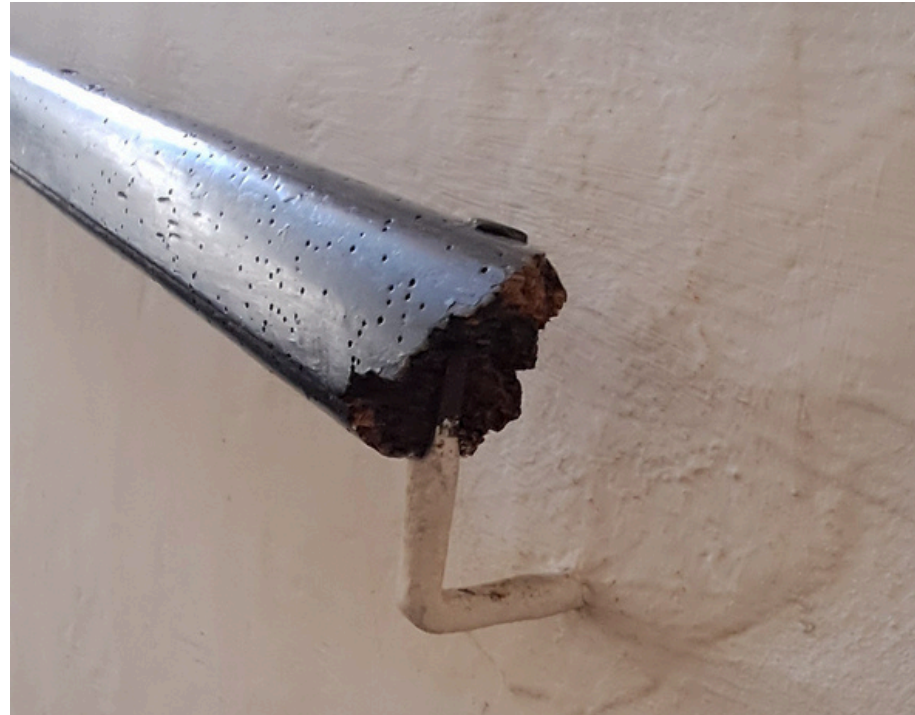
Fotografia corrimano ligneo particolare dell'attacco a muro
